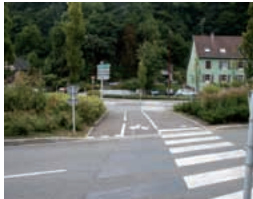
Traversée jouxtant celle des piétons (photo : Cete de l'Est)
