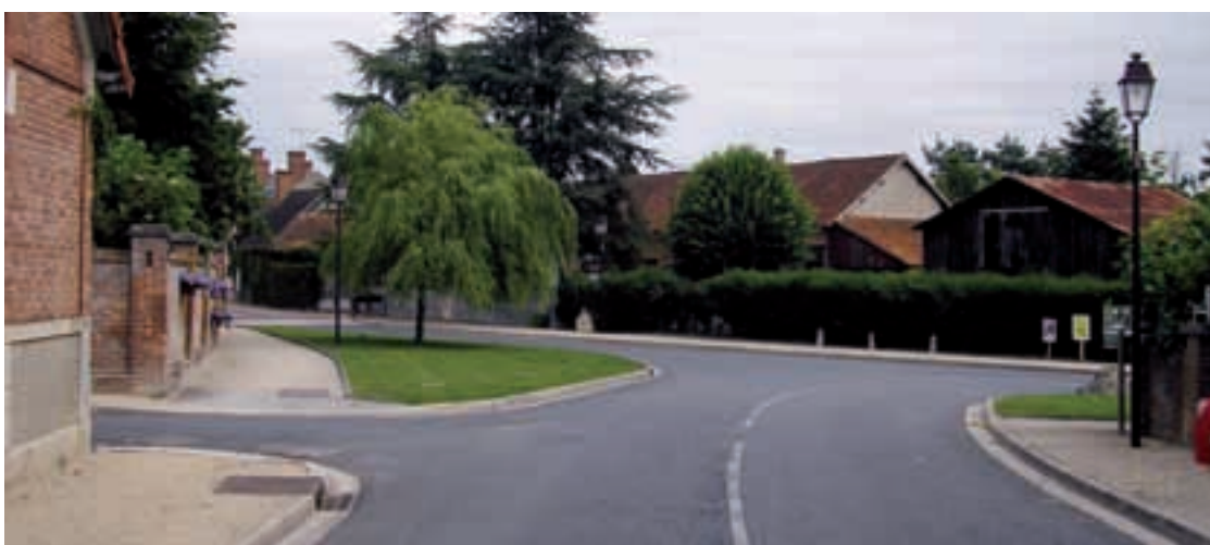
Après aménagement ; les voies sont orthogonales, limitant l'espace roulant (photo : Cete Normandie-Centre).
