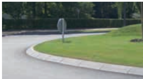
Îlot central ceinturé par des bordures ayant un profil non agressif et dont l'image est plus urbaine que les celles de type A ou I (photo : Cete de l'Est).
