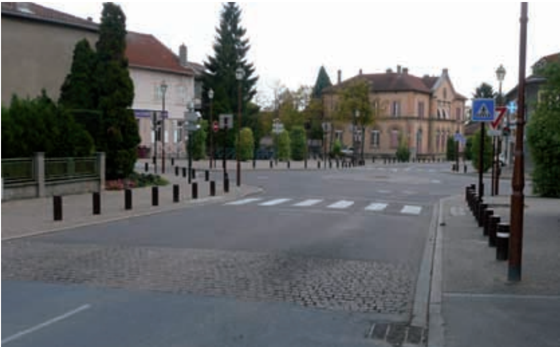
Passage piéton surélevé (photo : Cete de l'Est)
