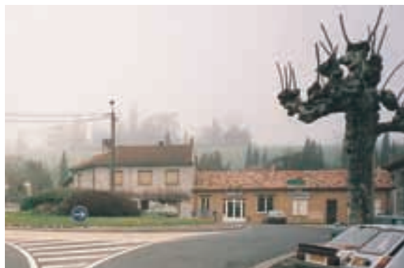
En approche, ce carrefour ressemble à un giratoire. En fait, une ligne de cédez-le-passage se trouve sur l'anneau et sur les voies secondaires. Ce dispositif prêtant à confusion est à proscrire (photo : Certu).
