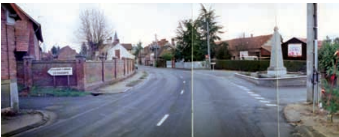
Avant aménagement : les voies se croisaient en biais, configuration favorable aux vitesses élevées.
