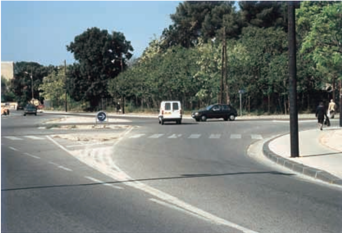
Priorité à droite refusée due à un problème de hiérarchie apparente entre les voies et de lisibilité.
