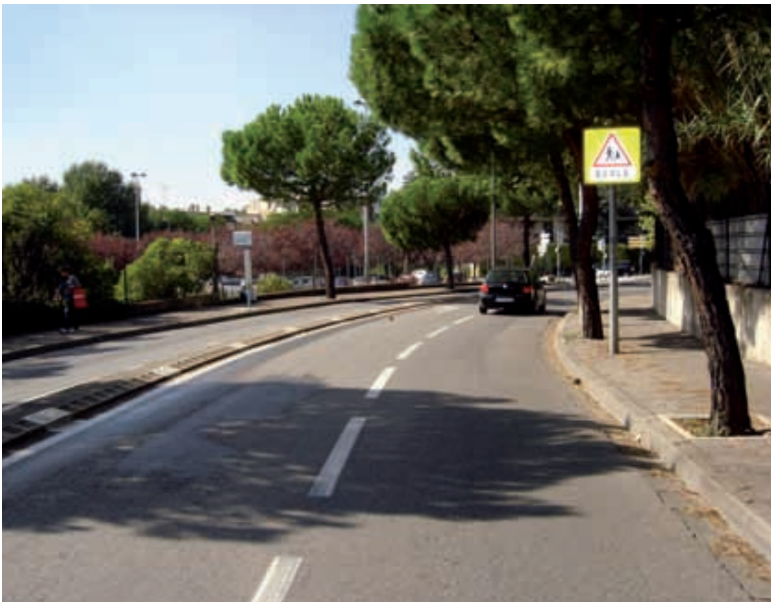
Défaut de visibilité du carrefour : les feux tricolores sont masqués par les arbres (photo : Cete Méditerranée)
