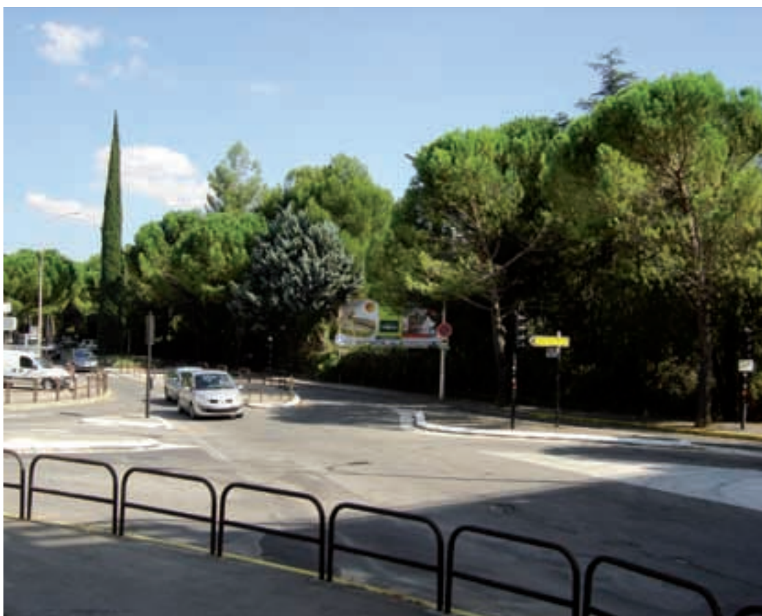
Espace roulable démesuré et géométrie complexe (photo : Cete Méditerranée)
