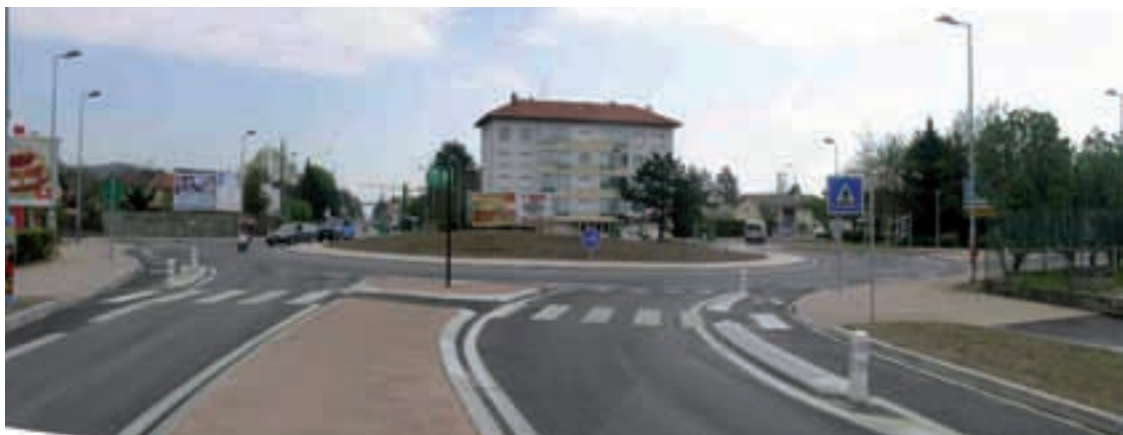
Petit îlot protégeant les cyclistes circulant sur la bande cyclable. La bande cyclable sur l'anneau est toutefois déconseillée (photo : Cete de l'Est).
