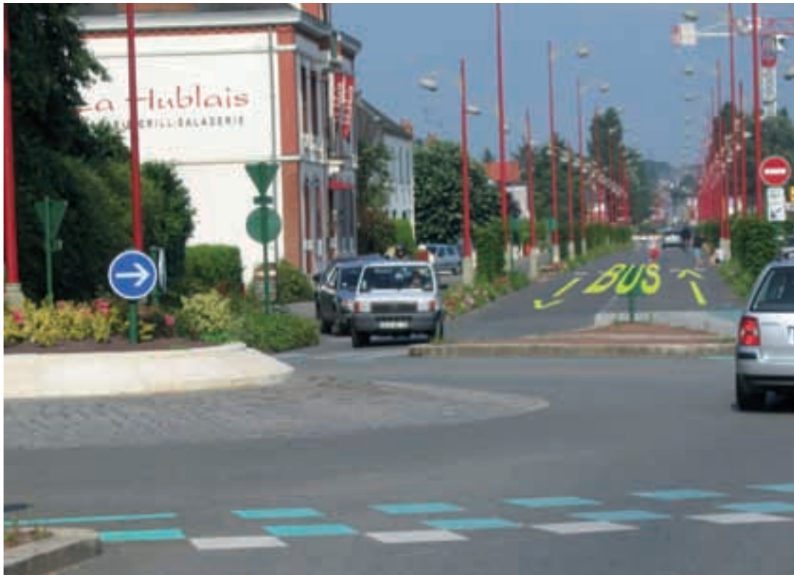
La voie de circulation générale est rabattue sur le site TC axial avant l'arrivée sur le giratoire (photo : Cete Normandie-Centre).
