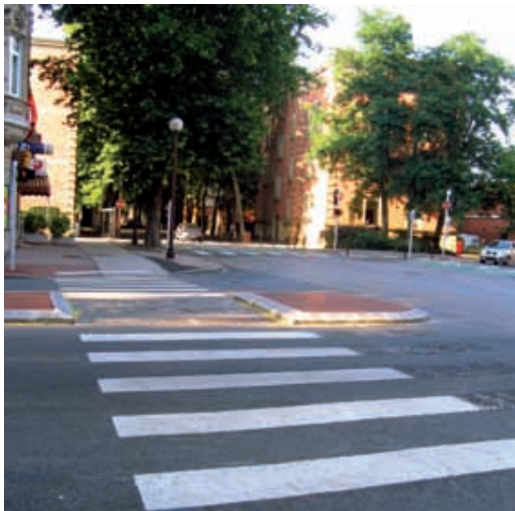
Après aménagement : un simple îlot refuge sécurise la traversée des piétons, qui peut se faire en deux temps. (photo : Cete de l'Est)
