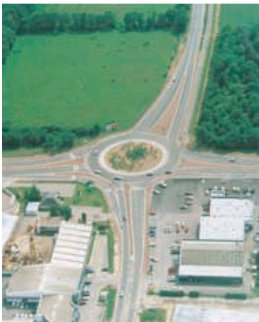
Giratoire à forte capacité en milieu urbain
