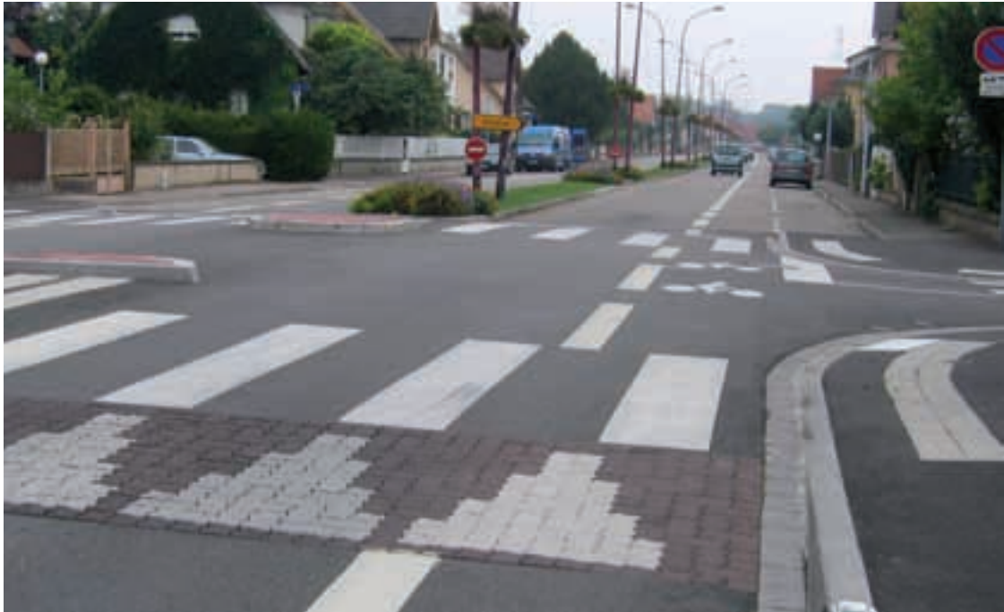
Continuité de leur cheminement et lisibilité des aménagements, modération de la vitesse sont des éléments, parmi d'autres, à considérer pour la prise en compte des cyclistes dans l'aménagement d'un carrefour (photo : Cete de l'Est).
