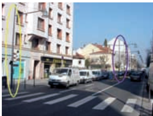
Au droit d'un carrefour, les luminaires sont implantés souvent en latéral. Les candélabres peuvent servir de support aux feux tricolores s'ils ont été dimensionnés à cet effet (norme EN 40 29 ) (photo : Certu).
