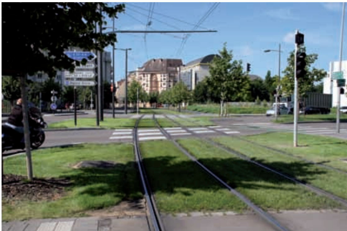
Tramway en site propre (photo : Cete de l'Est)
