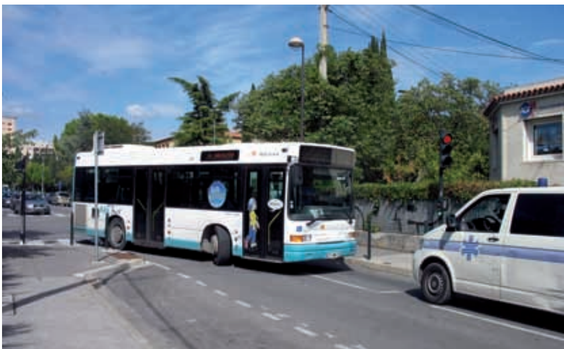
Carrefour à feux avec une ligne d'effet des feux reculée pour prendre en compte la giration du bus (photo : Cete d'Aix)
