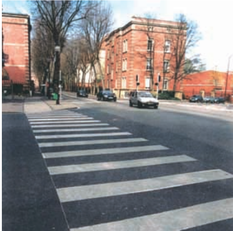
Avant aménagement : la traversée piétonne était dangereuse (photo : Cete de l'Est)
