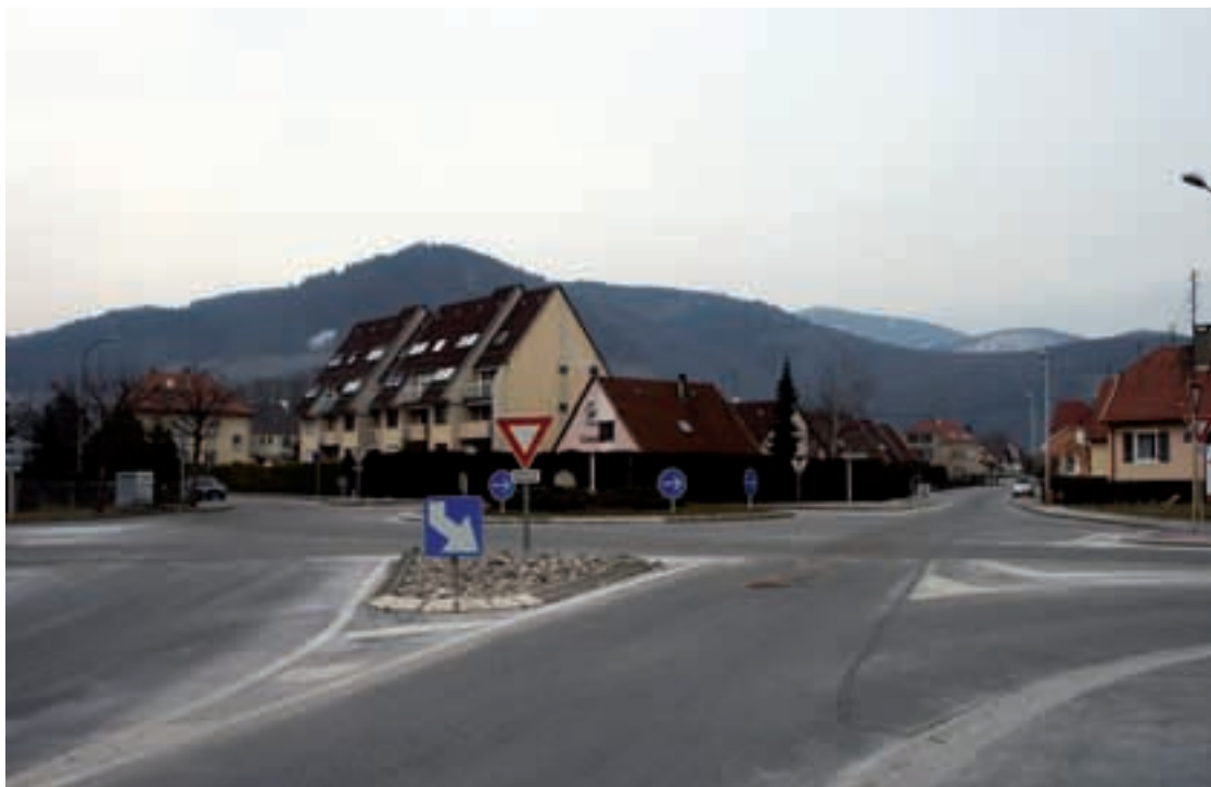
Une trajectoire directe génère des vitesses excessives et une mauvaise visibilité du carrefour (photo : Cete de l'Est)
